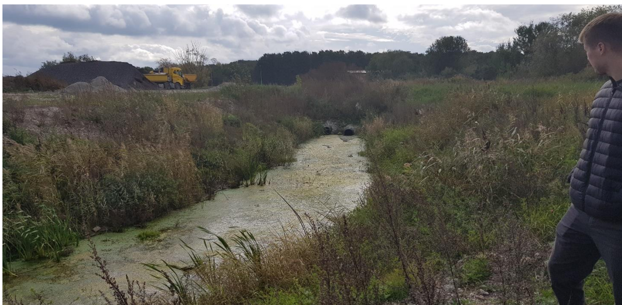
Foto 6 Ala lõunaosas asuv sügav ja lai kraav, kuhu täna on suunatud ka reoveekanaliseatsiooni avariilask
