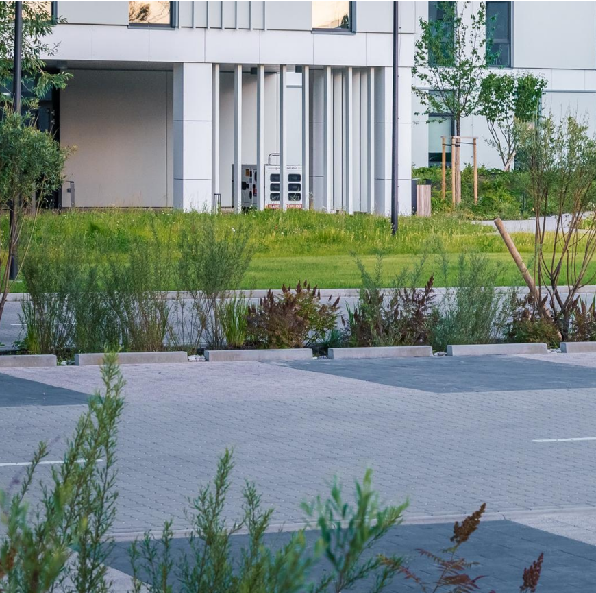
PRINCIPĀLA SHĒMA - PĀRTRAUKTI BORTAKMEŅI
